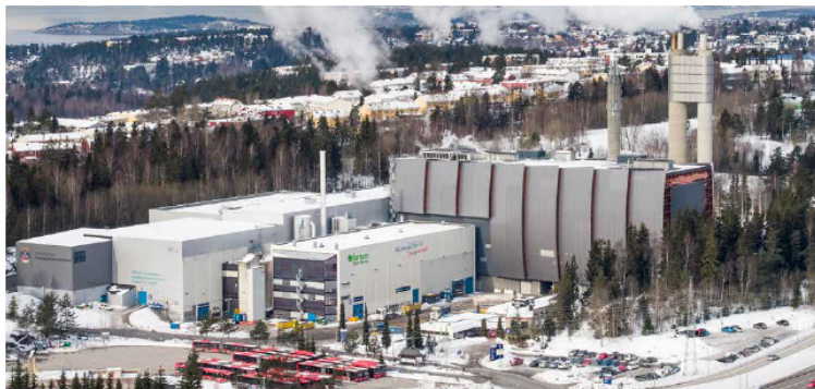
Det blir «klart dyrere» enn først antatt å fjerne CO 2 fra utslippene til avfallsanlegget på Klemetsrud. FOTO: HANS D. TORGENSEN
